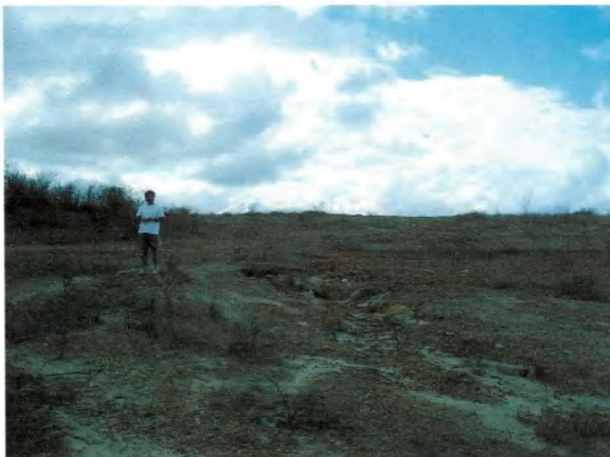
Figura 14 – Área degradada com formação de sulco (Lat. 7° 14' 52,5" e Long. 35° 56' 8,3")
