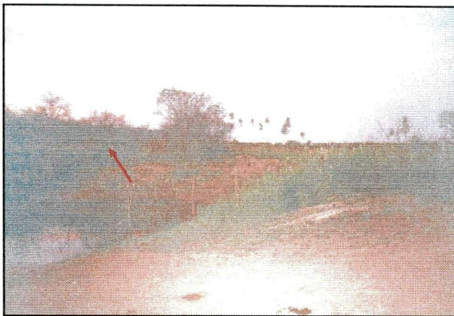
FIGURA 50 – Ocupação agrícola do açude na localidade Olho D'água dos Caboclos – Amparo.
