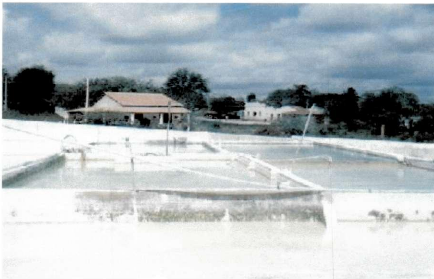
Figura 2.7 – Tanques de separação e sedimentação do caulim
