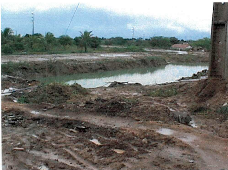
FIGURA 2.6 – Exemplo de um tanque de decantação, onde são dispostos os resíduos da serragem de granitos.
