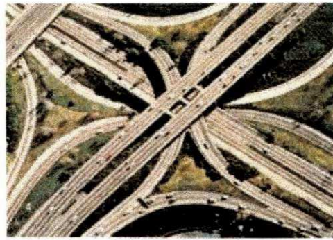
FIGURA 4.2 – Interseção em Desnível com Ligação entre as Vias Fonte: FURQUERON'S (2001).
