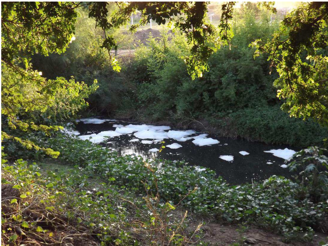
Fotografia 2 - Estação de Tratamento de Esgotos de Sousa
