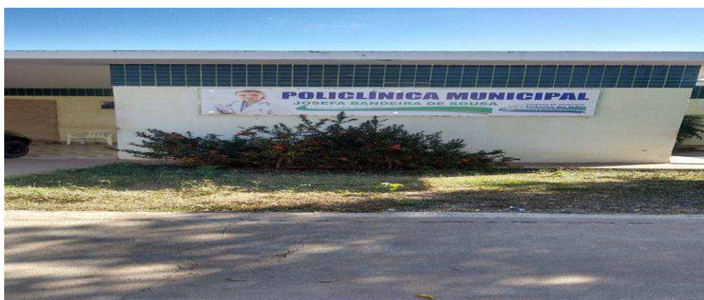
Foto 5: Policlínica Municipal (antigo hospital) em Cachoeira dos Índios
