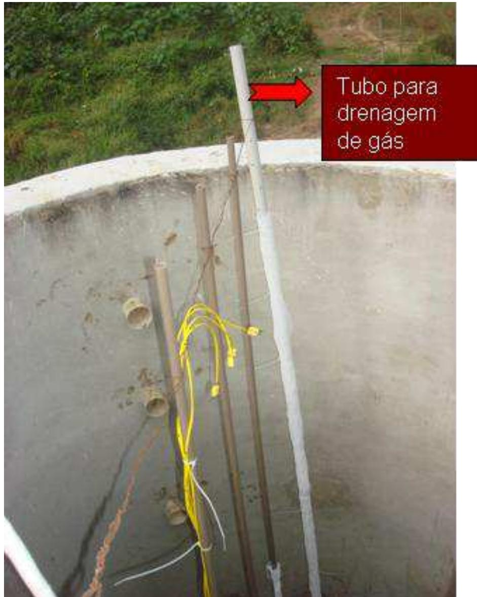
**Figura 10: Tubo para drenagem de gases**
