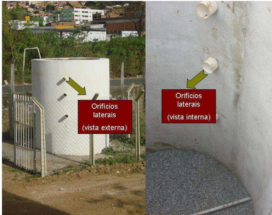
**Figura 18: Orifícios laterais (detalhes) para coleta de amostras em diferentes profundidades**
