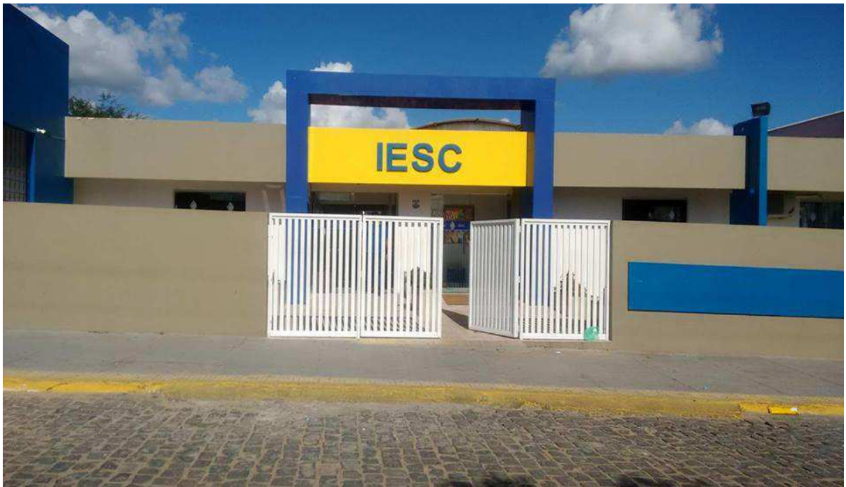
FIGURA 2: Fachada do Instituto Educacional de Santa Cruz.
