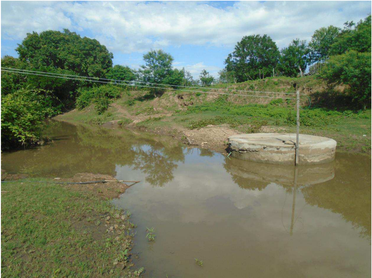
Figura 8 - Abertura de poços dentro do leito do rio para suprir a necessidade de abastecimento/consumo.
