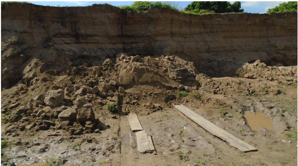
Figura 4 - Desmoronamento de encostas provocado pela extração de areia no rio Piranhas, Sítio Lagoa de Dentro, São José de Piranhas-PB.
