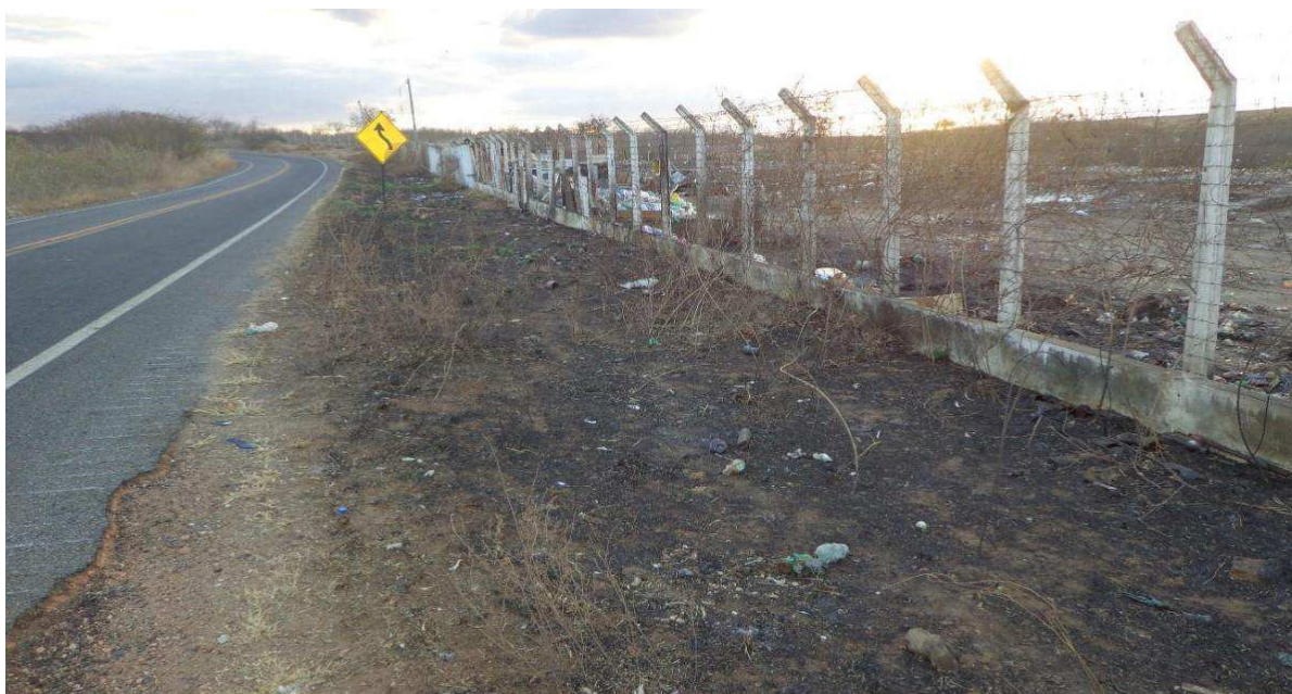
Foto 6: incêndio florestal entorno do lixão
