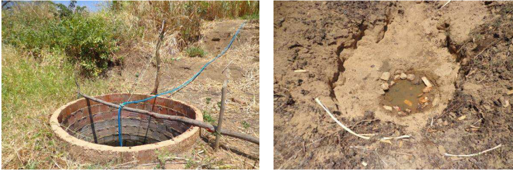
Figura 13: Poço Amazonas - Cacimba no leito do riacho. Figura 14: uma cacimba no leito do riacho.
