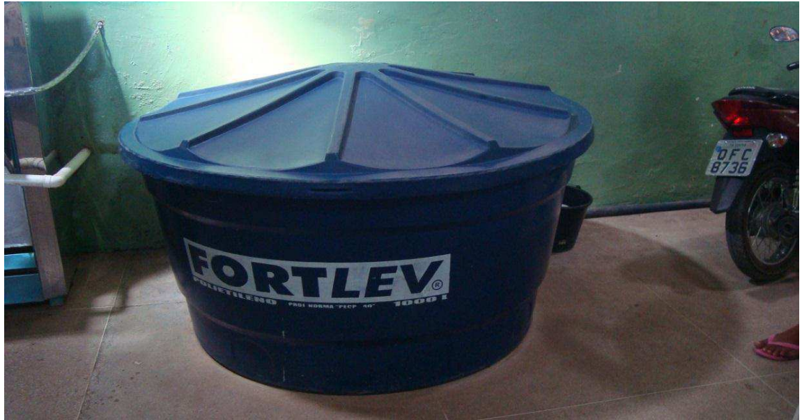
Foto 03-: Caixa de Água
