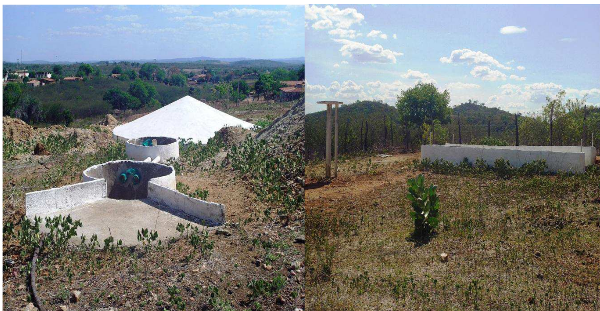
Foto 12: Cisterna de enxurrada. Observemos a Cisterna armazenada no solo, e ao lado um canteiro usado para a produção de legumes e frutas.
