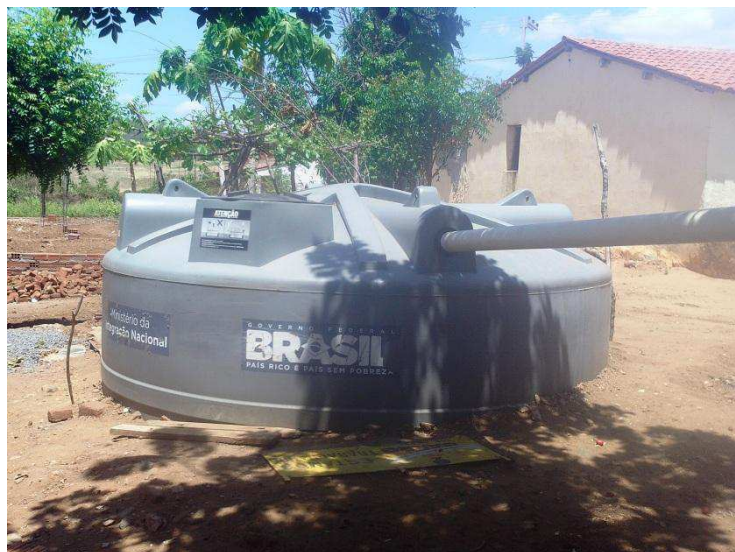
Foto 14: Cisternas de Polietileno para o armazenamento de água da chuva. Foto da autora, Jan 2015.
