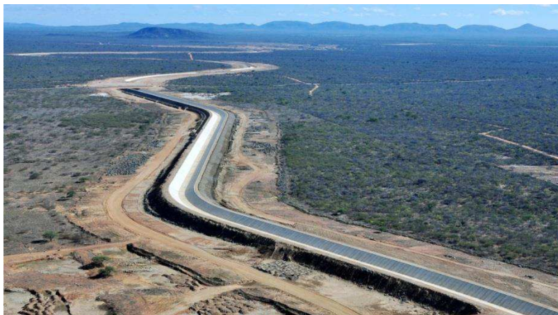
Figura VI: Canal da transposição do São Francisco. Fonte: Ministério da Integração Nacional
