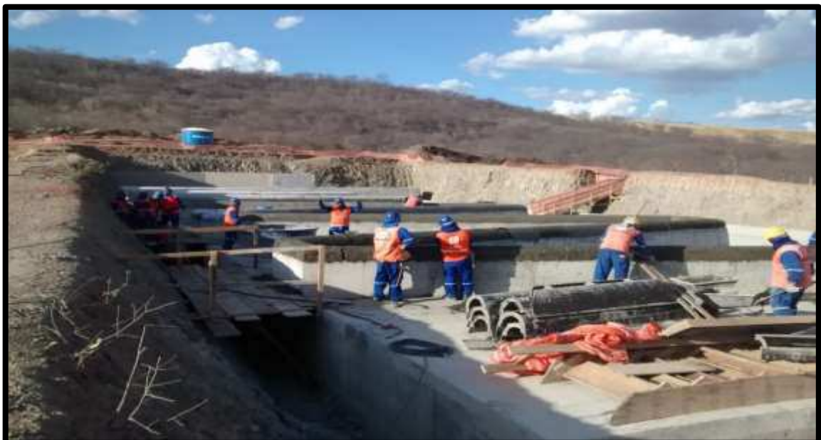
Figura 15 – Operários em Atividade – Construção do Dique Pereiros.
