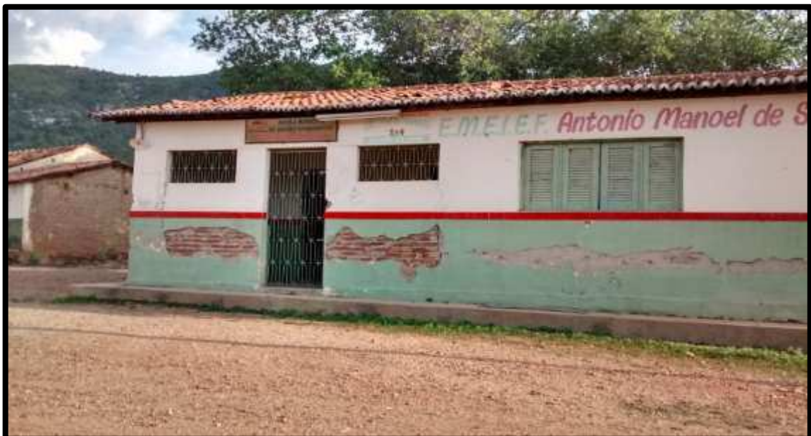
Figura 19 – Unidade Escolar Desativada
