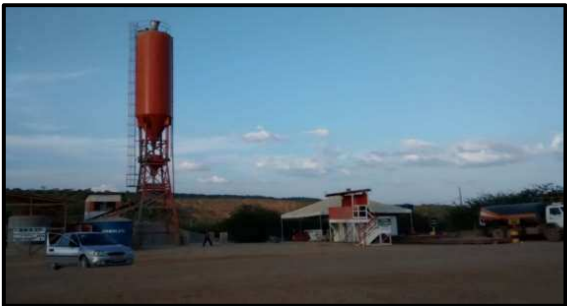
Figura 14 – Canteiro de Obras – Povoado de Boa Vista.
