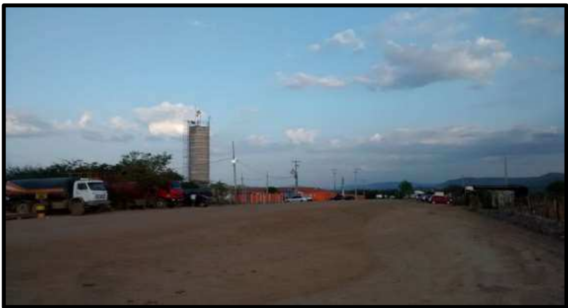
Figura 18 – Alojamento construído nas proximidades do canteiro de obras.
