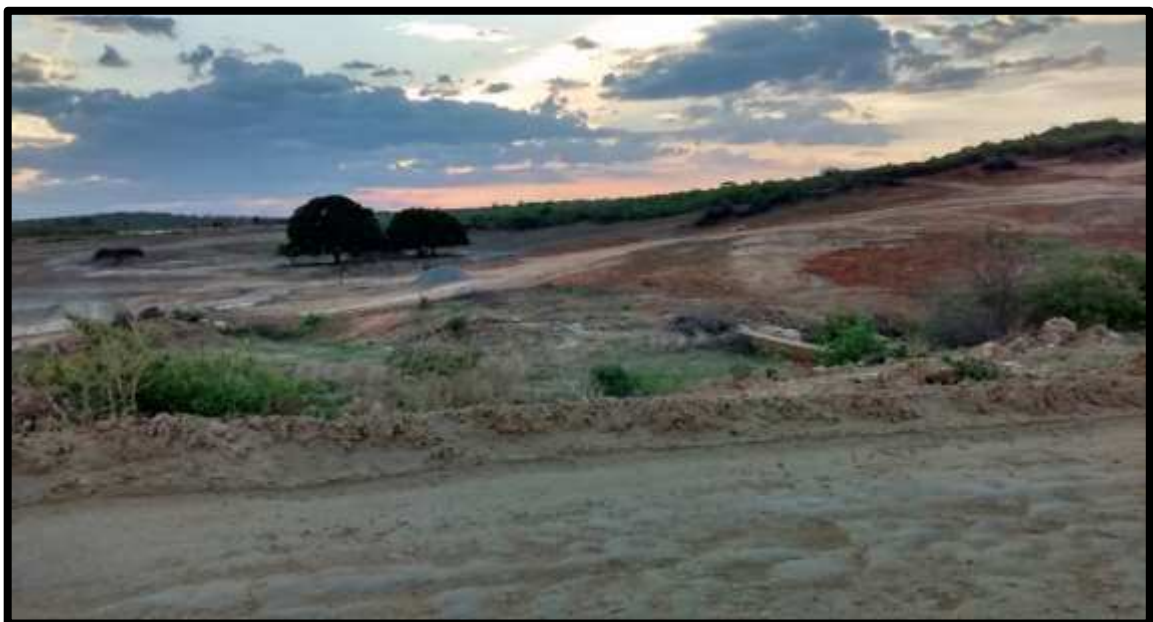
Figura 16 – Área Desmatada – Construção da Barragem de Boa Vista.
