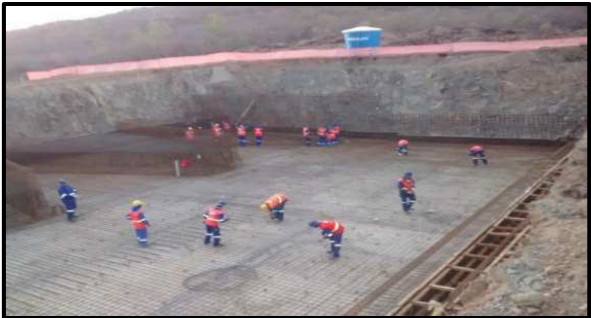
Figura 13 – Operários em Atividade – Construção da Barragem de Morros.
