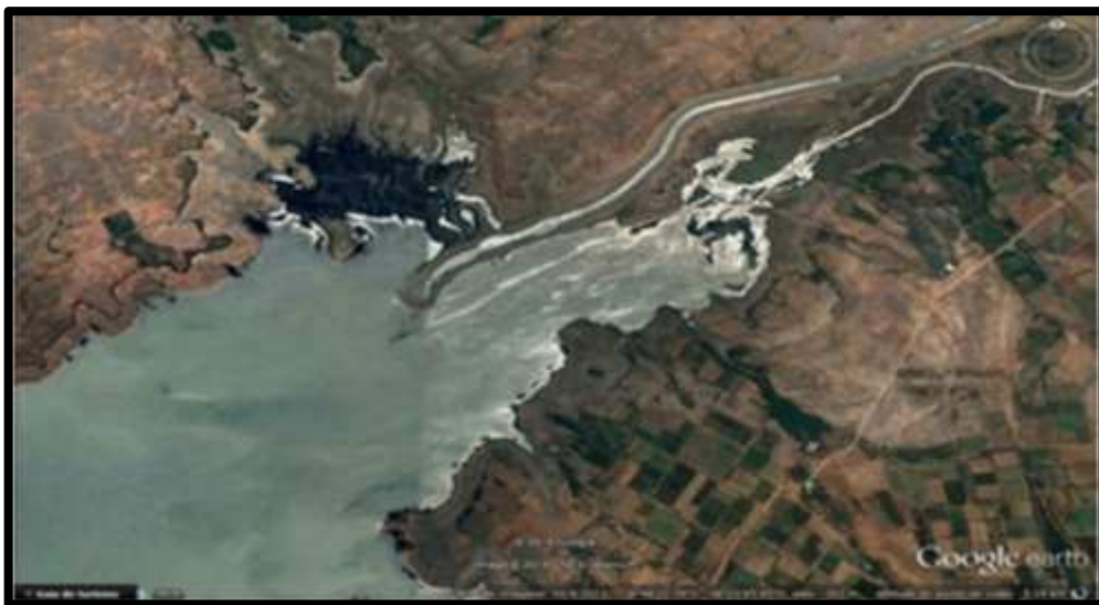
Figura 02 – Ponto de Captação do Eixo Leste 2 .
