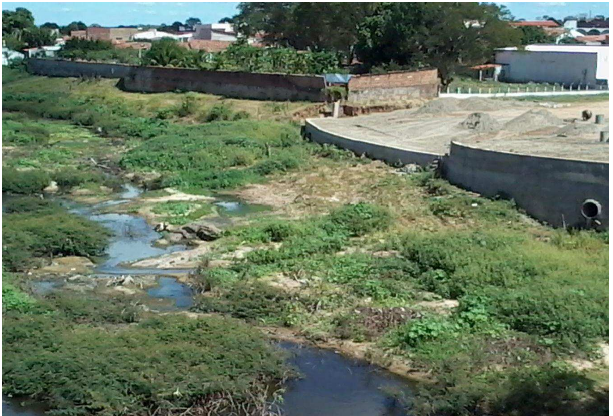
FIGURA 12 — DESPEJO DE ESGOTO — PONTO 3
