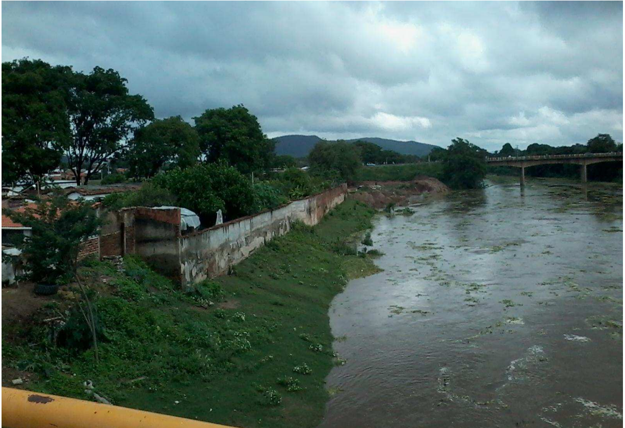
FIGURA 7 — INVASÃO DE RESIDÊNCIAS — PONTO 2
