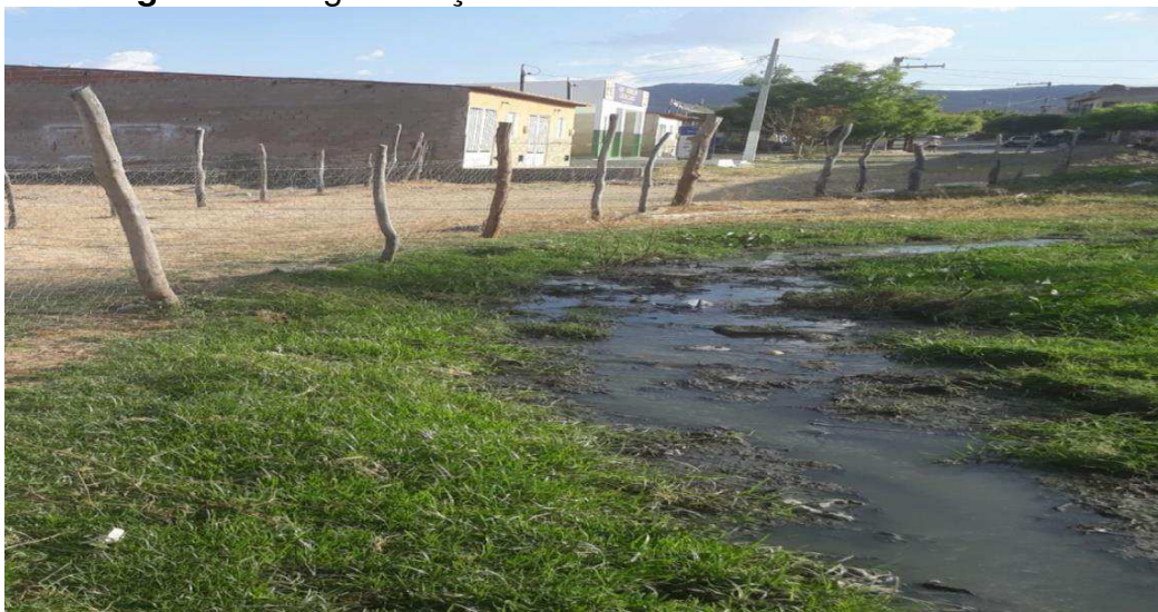
Imagem 04: Esgoto lançado in natura a céu aberto sobre o solo.
