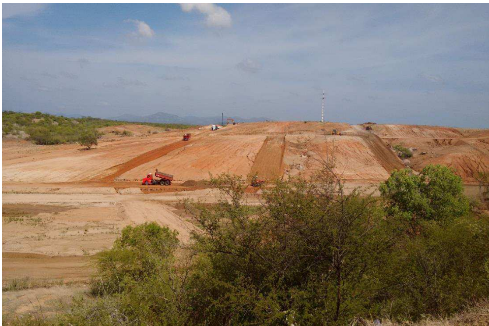
Foto 07: Construção do loteamento. Fonte: Autor (2015).
