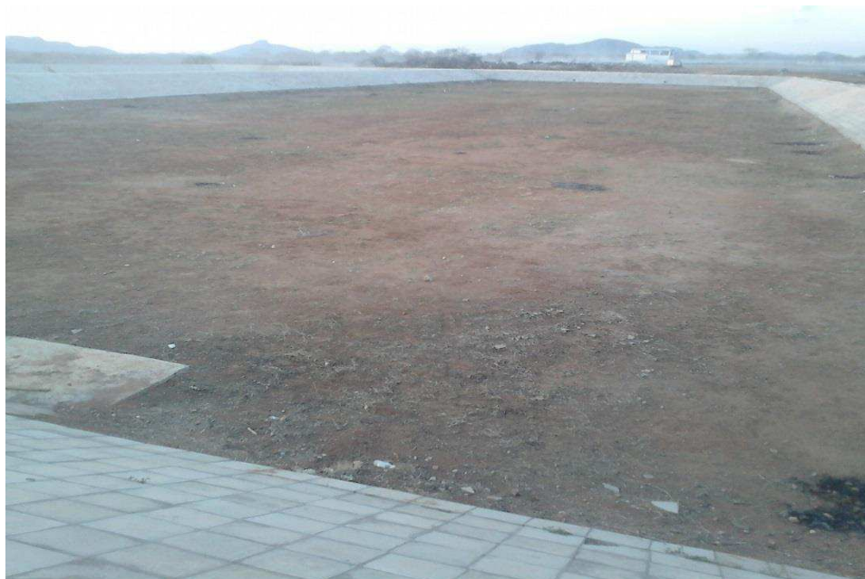
Foto 08: Piscina da estação de tratamento de esgoto.
