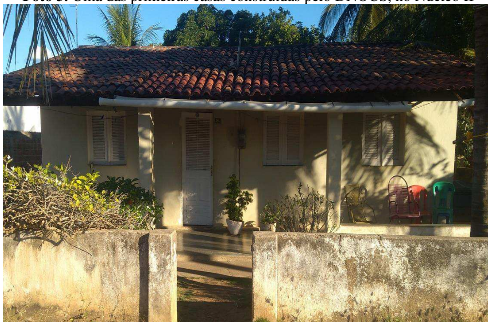
Foto 3. Uma das primeiras casas construídas pelo DNOCS, no Núcleo II
