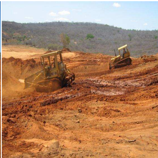
Figura 28- Retirada do solo para reforço da parede
