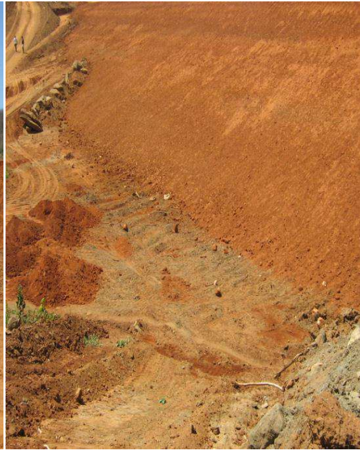
Figura 28- Retirada do solo para reforço da parede
