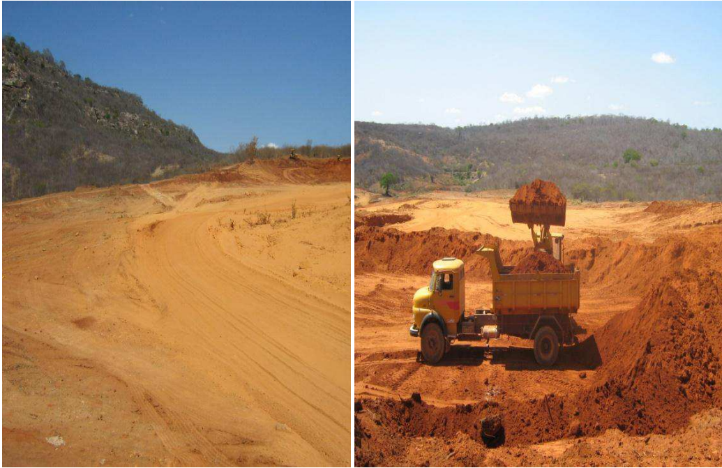
Figura 23- Solo descoberto e impactado. Figura 24- Construção da parede do açude.
