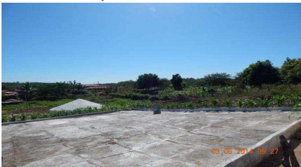
Foto 18 – A Cisterna Calçadão
