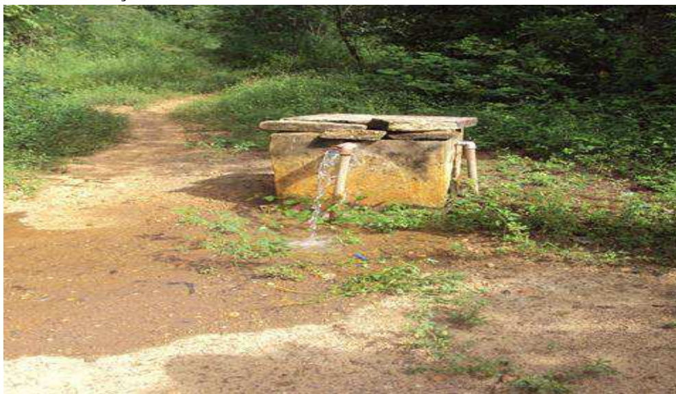
Foto 15 – Poço Artesiano Comunitário
