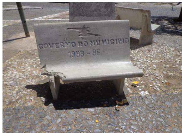
Foto 25- Praça Galdino Pires. Precário estado de conservação do mobiliário, agosto de 2014 (foto da Autora).
