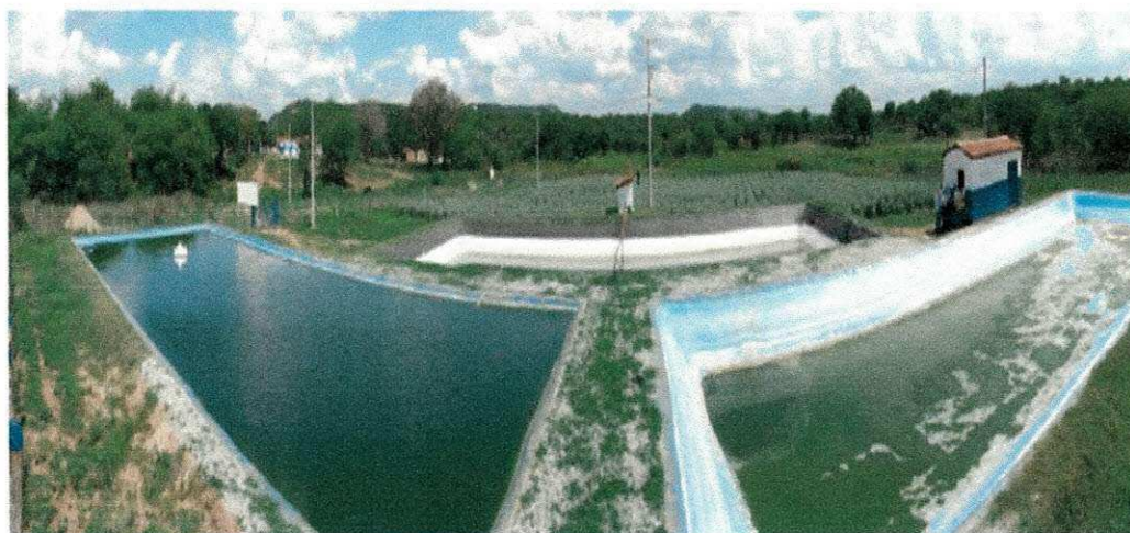
Figura 3 - Tanques e reservatório do PAD, Amparo (PB).
