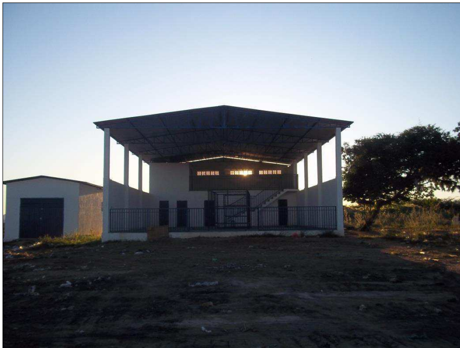
Foto 10 – Galpão de triagem da Unidade de Beneficiamento de Resíduos Sólidos
