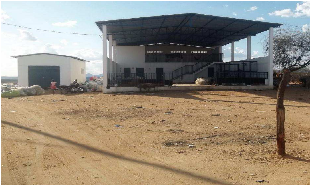
Figura 10: Galpão sede da (ASCARMAP) no município de Pombal –PB.
