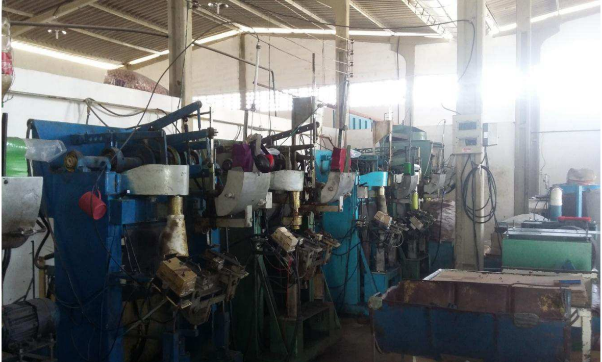
Figura12: Máquinário da Fábrica ICOPLAST, Pombal- PB
