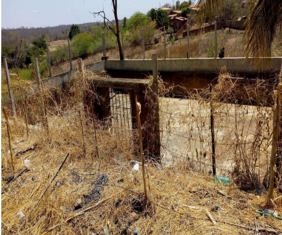
Figura 7- Segunda Caixa construída para receber água do rio e ser enviada aos canais de irrigação
