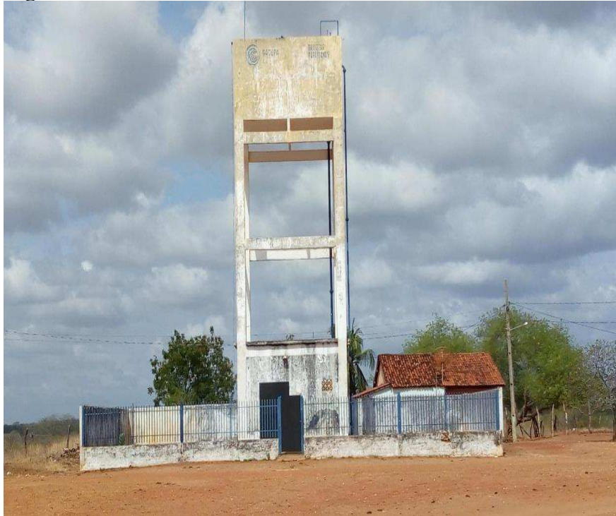
Figura 3- Prédio da CAGEPA
