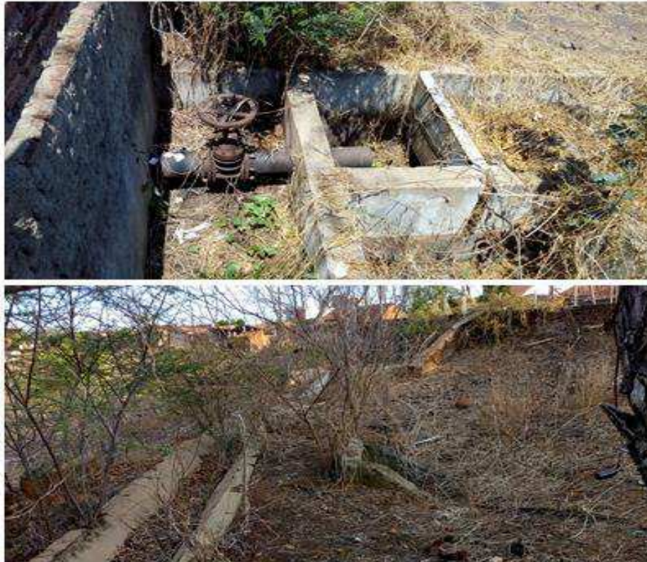
Figura 9- local por onde a água passava da caixa para o canal
