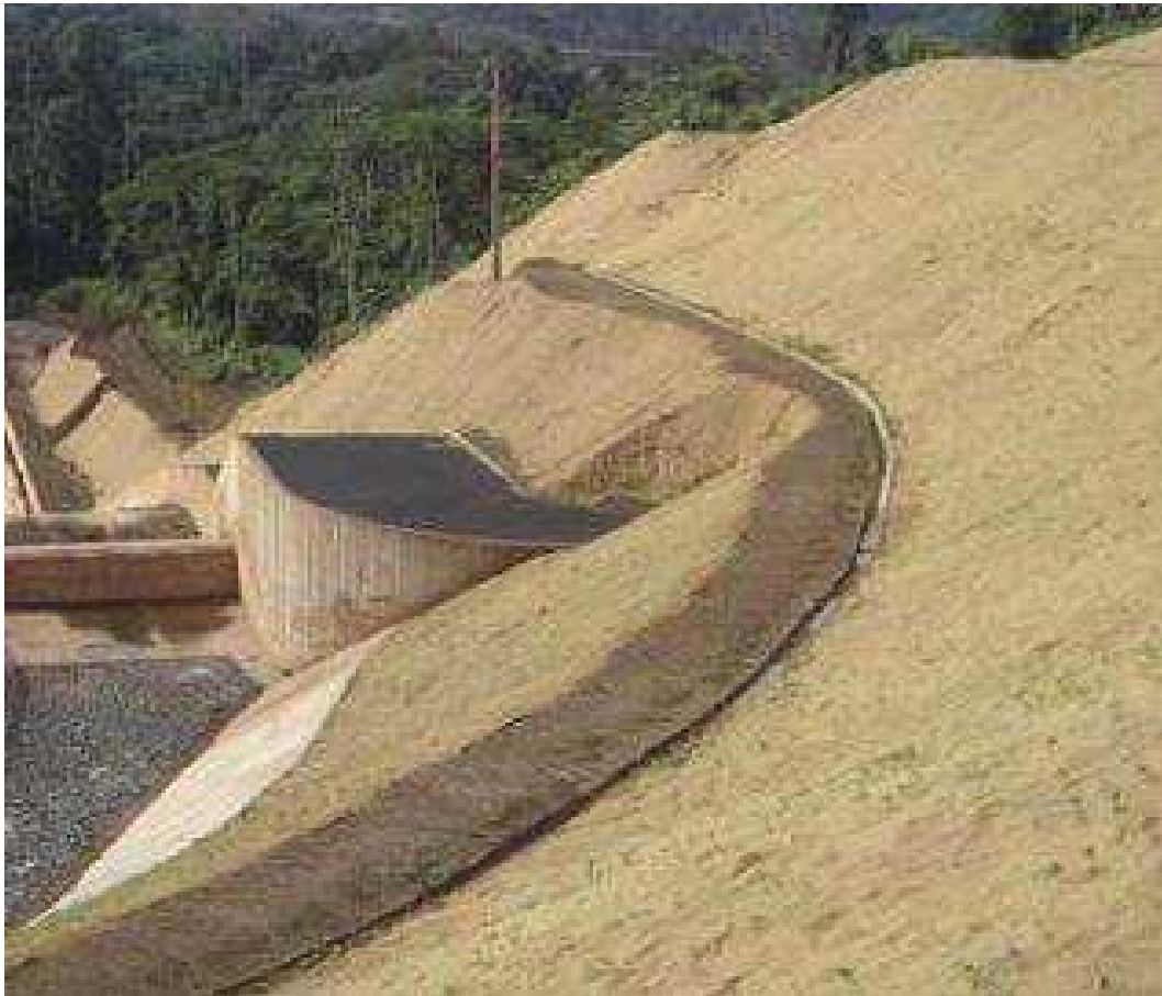
Figura 15: Mantas de retenção feitas de fibra de coco
