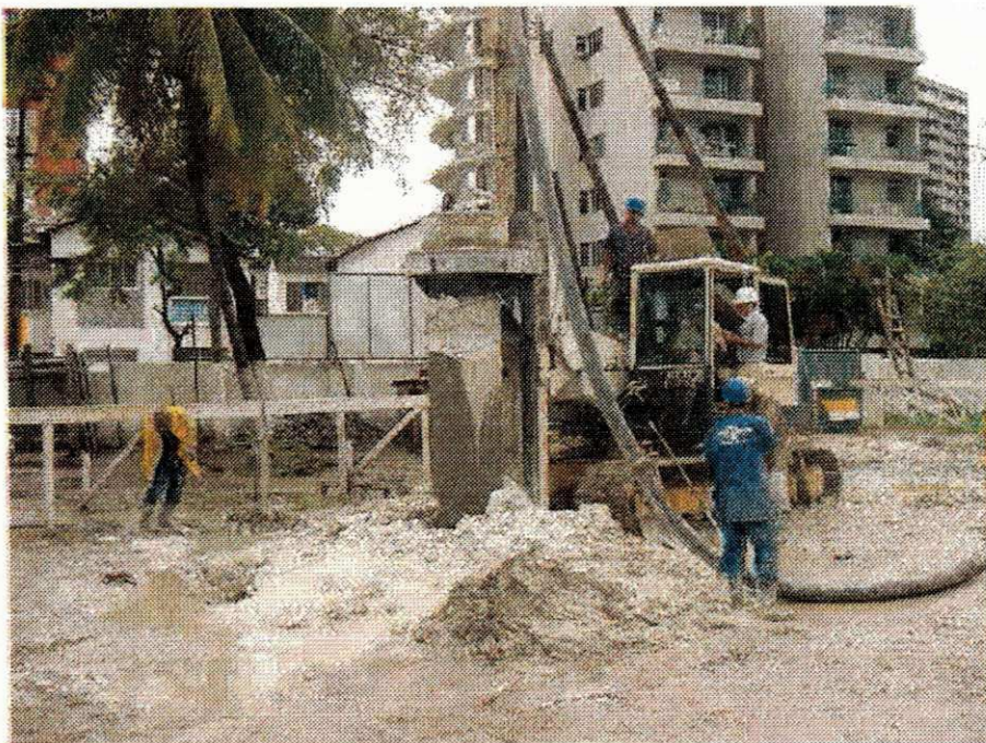
Figura 3.12 – Foto do processo de execução da estaca hélice contínua.
