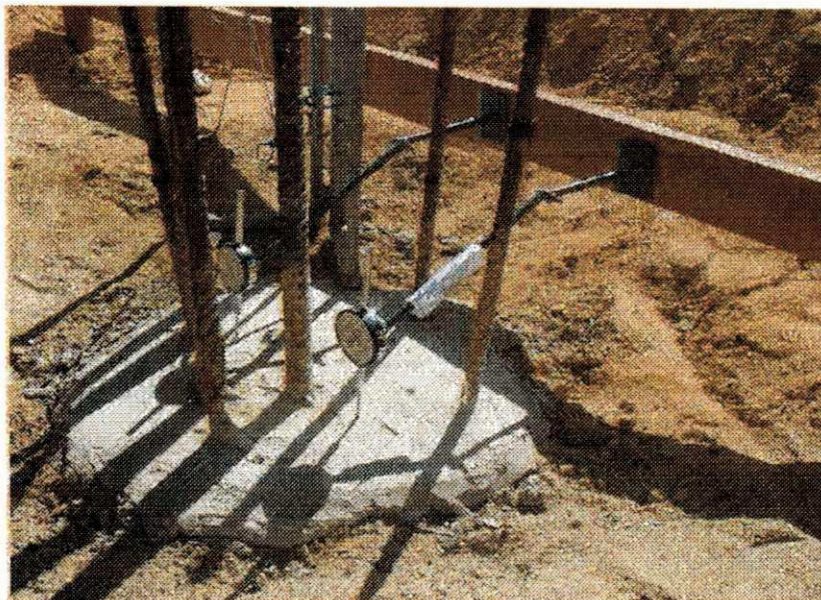
Figura 3.17 – Posicionamento dos relógios comparadores no topo das estacas de reação.
