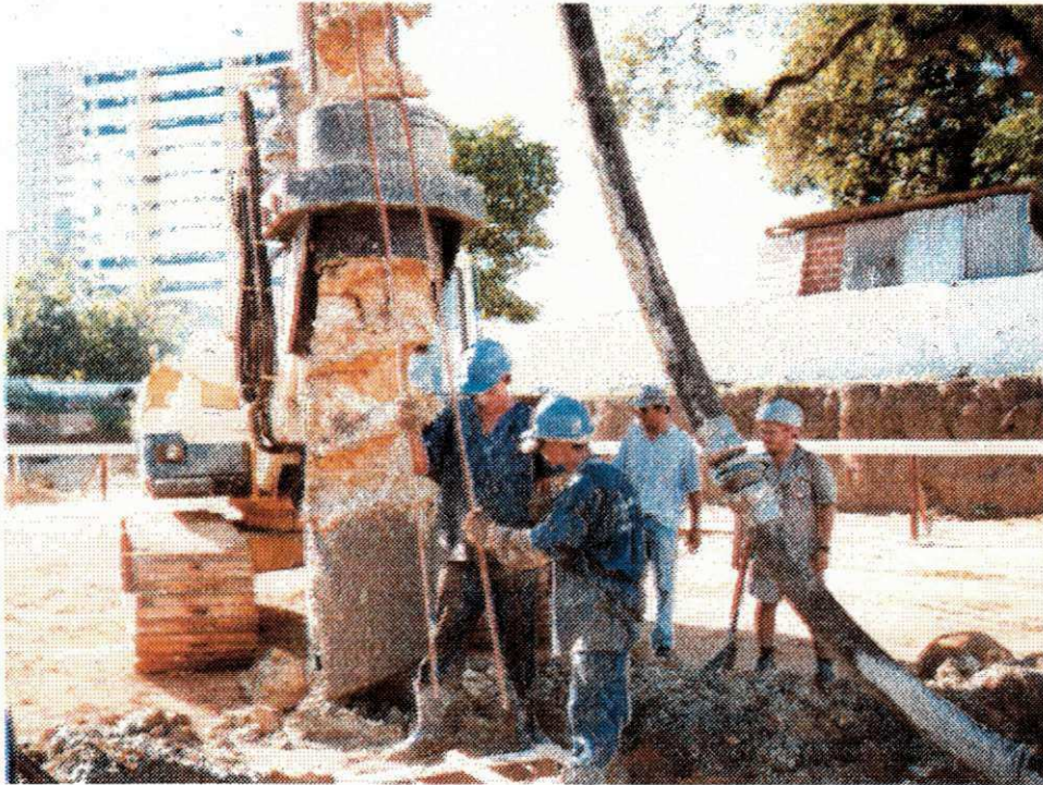
Figura 3.13 – Foto da colocação da ferragem na estaca hélice contínua.
