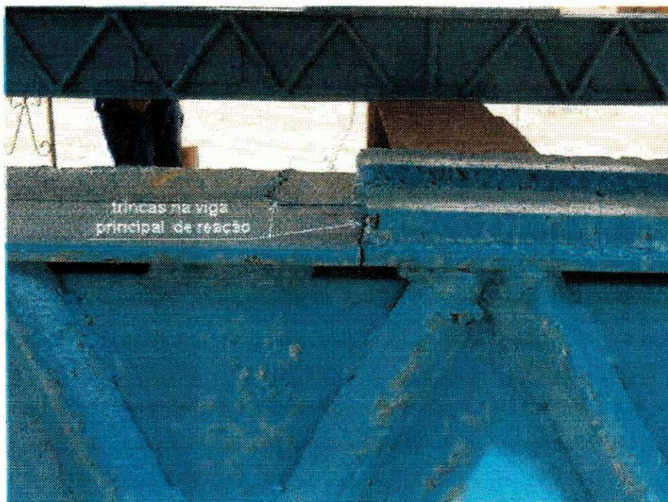
Figura 3.23 – Detalhes das trincas na viga principal de reação durante realização das provas de carga na estaca E107 do Edifício Aderbal Jurema.
