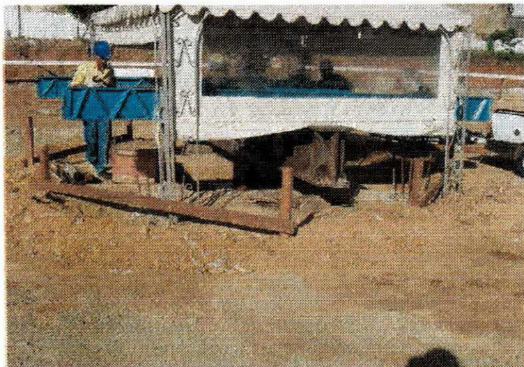
Figura 3.15 – Vista geral do sistema de reação empregado na estaca E107.
