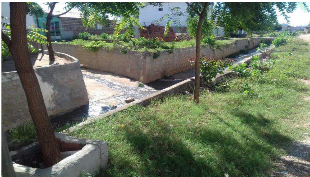
Fotografia 04 – Encontro das galerias 01 e 02.
