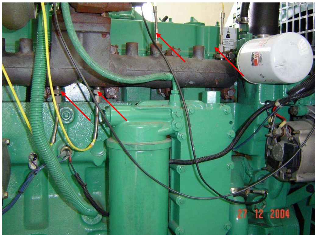
Figura 3.5 - Termopares instalados no coletor de escapamento.
