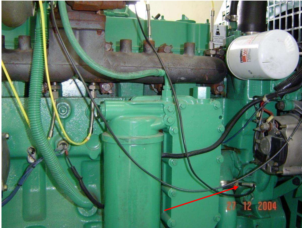
Figura 3.10 - Termopar instalado para medição da temperatura da água na entrada do motor
