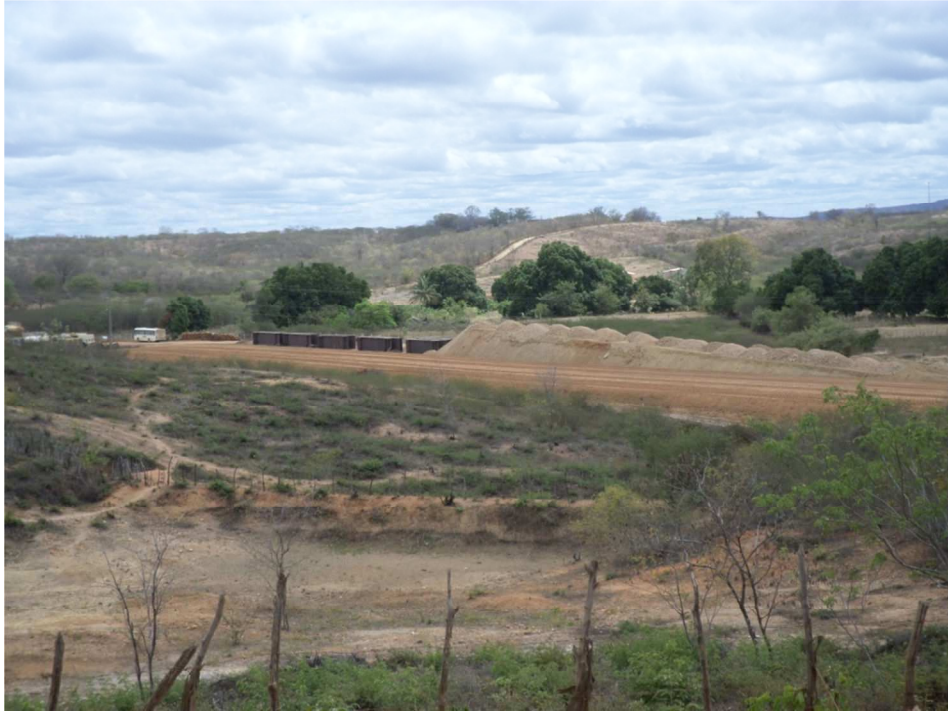
Figura 13. Foto de um dos trechos da obra. Elaborada pela autora.
