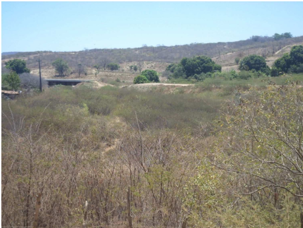
Figura 14. Foto de um dos trechos da obra. Elaborada pela autora.
