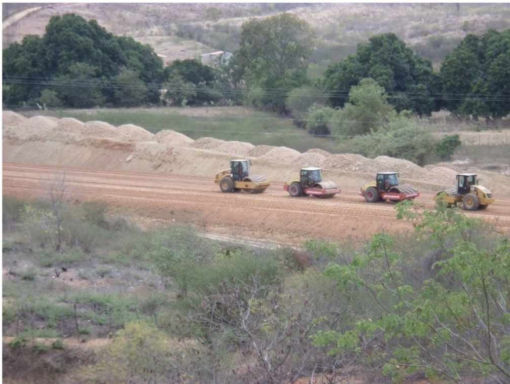
Figura 15. Foto de um dos trechos da obra. Elaborada pela autora.
