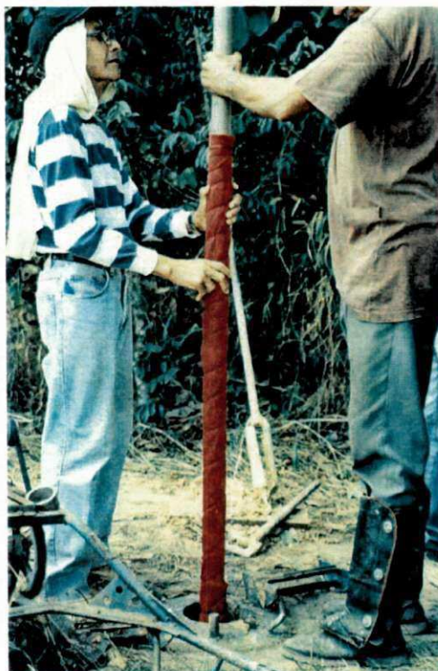
Figura 3.7 – Instalação de medidor de nível d'água, onde a parte ranhurada do tubo de PVC está protegida por um tecido sintético para evitar a entrada de partículas no tubo.
