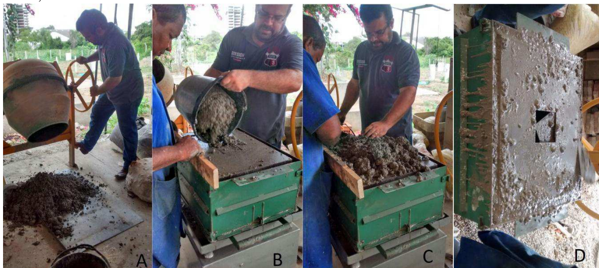
Figura 7.7 A: Preparadas em betoneira; 7B e C: Deposição do concreto na forma de ninho pré-moldada; 7D: Adensamento do concreto em mesa vibratória.
