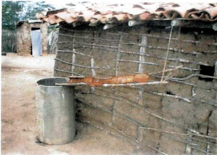
Figuras 16 e 17 - Improvisação de calhas e suportes com materiais inadequados.
