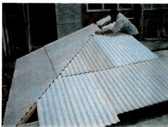
Figura 3 - Protótipo em construção.
