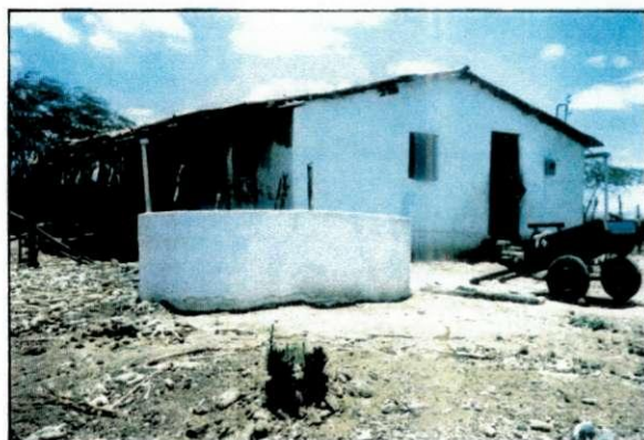
Figuras 18 e 19 – Cisternas construídas em locais distantes da casa para facilitar o acesso de carros-pipa. Na foto da direita, a captação de água de chuva parece ter papel secundário.
