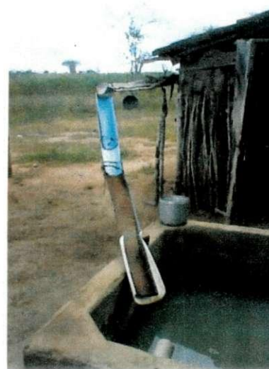
Figuras 16 e 17 - Improvisação de calhas e suportes com materiais inadequados.
