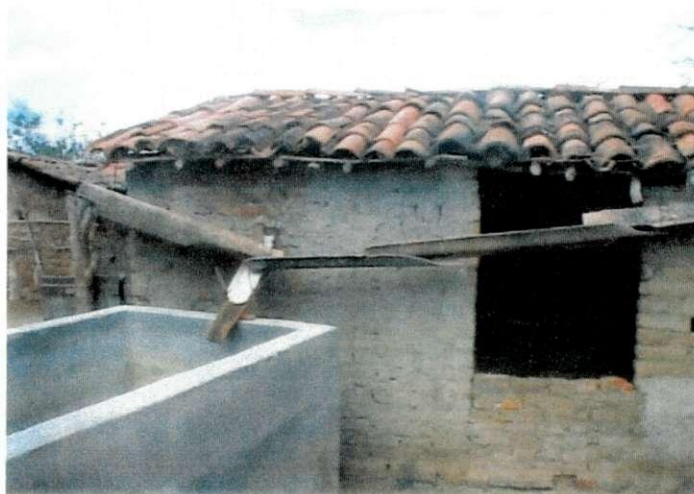
Figuras 14 e 15 - Calhas e dutos confeccionados por meio de reutilização de vários materiais.
