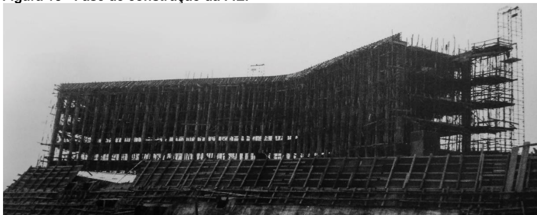
Figura 18 - Fase de construção da FIEP
