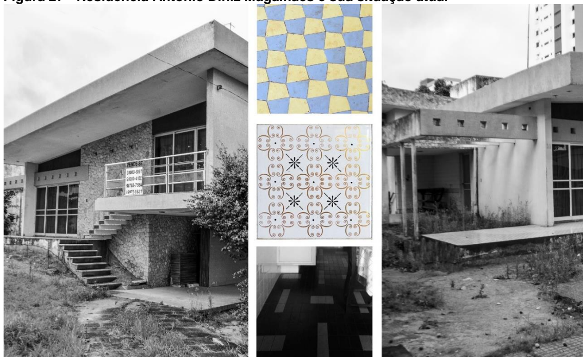
Figura 27 - Residência Antônio Diniz Magalhães e sua situação atual
