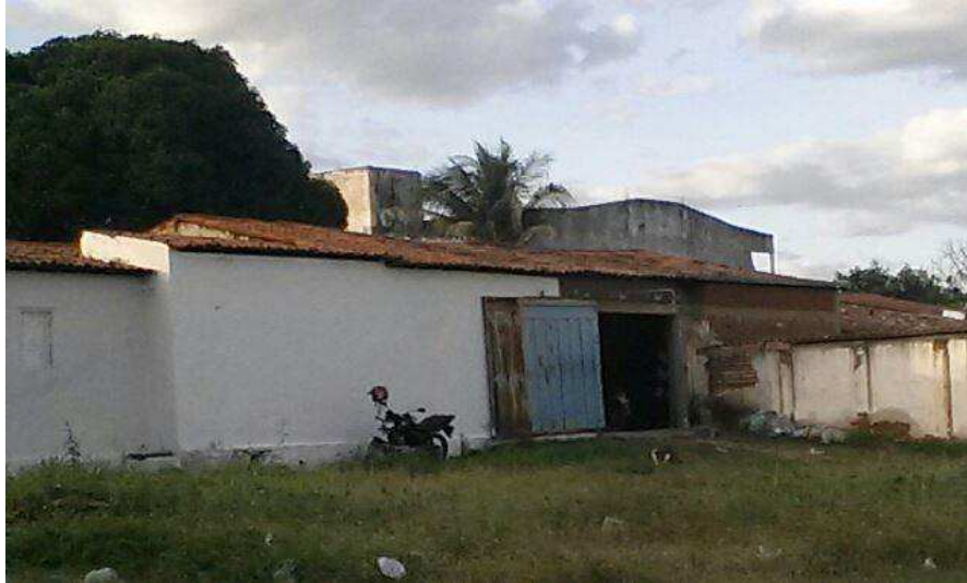
Foto 4: Tecelagem no instalada nos fundos da residência. Fonte: arquivos do autor (2016)
