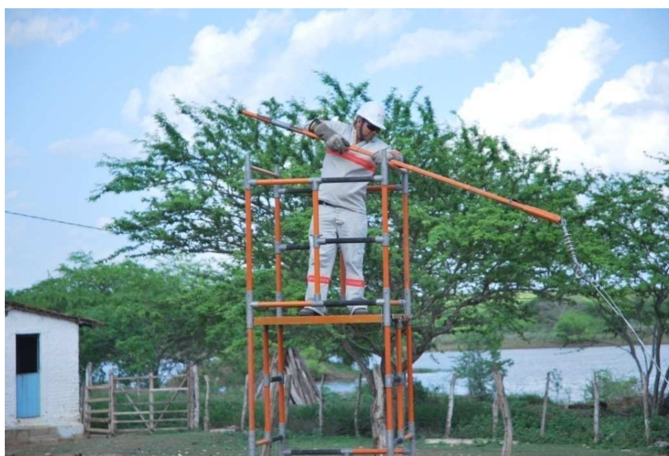
Figura 4.10. Técnico manobrando o condutor (Fonte: Próprio Autor).
