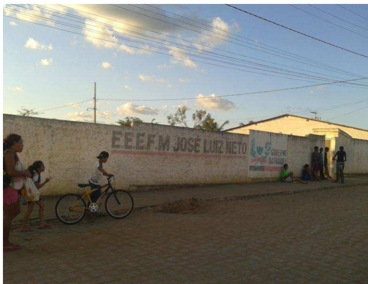
Figura 4: Fachada da escola Estadual de Ensino Fundamental e Médio José Luiz Neto
