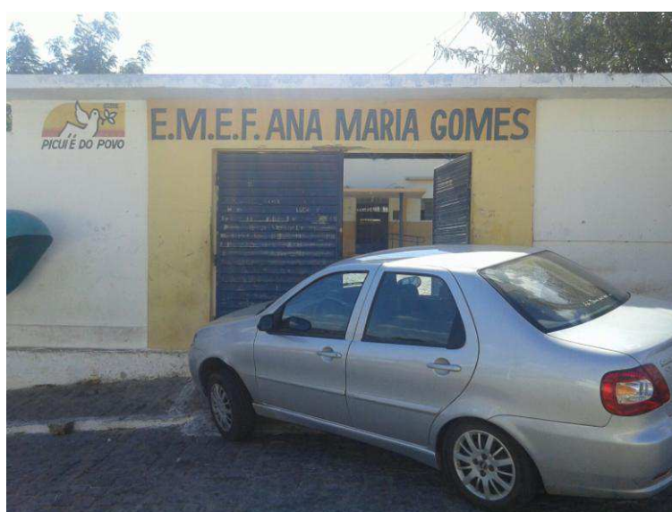
Figura 15: Fachada da Escola Municipal Ana Maria Gomes
