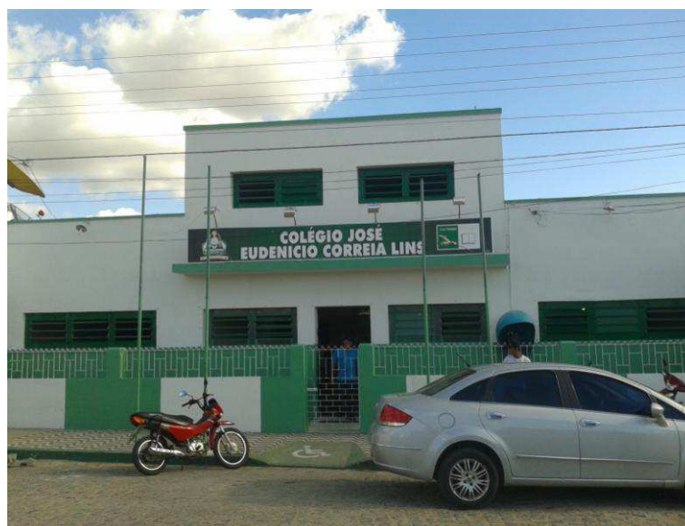
Figura 3: Fachada do Colégio Municipal José Eudêncio Correia Lins
