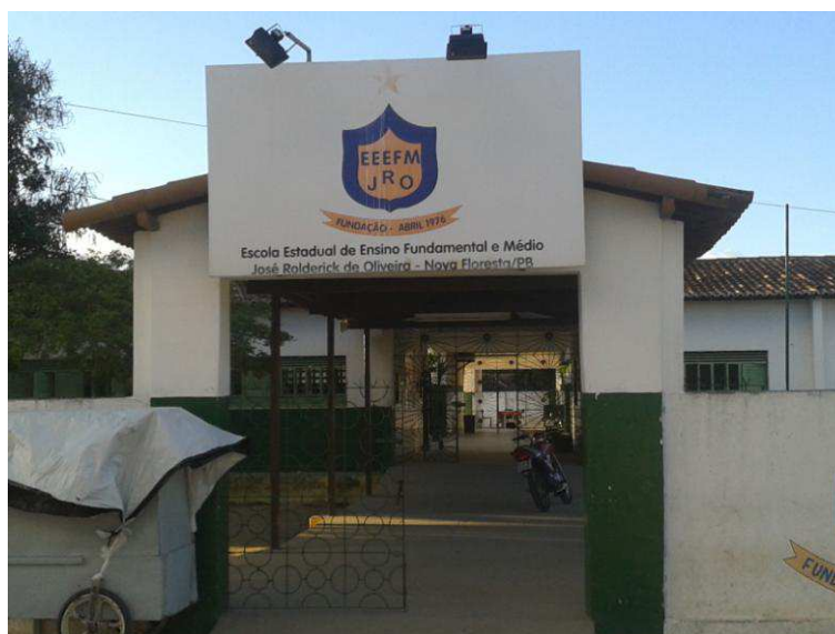
Figura 7: Fachada da Escola Estadual de Ensino Fundamental e Médio José Rolderick de Oliveira.
