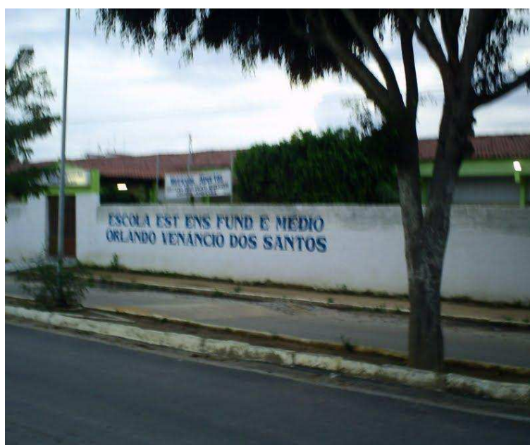
Figura 5: Fachada da escola estadual de ensino fundamental e medio Orlando Venâncio dos Santos.
