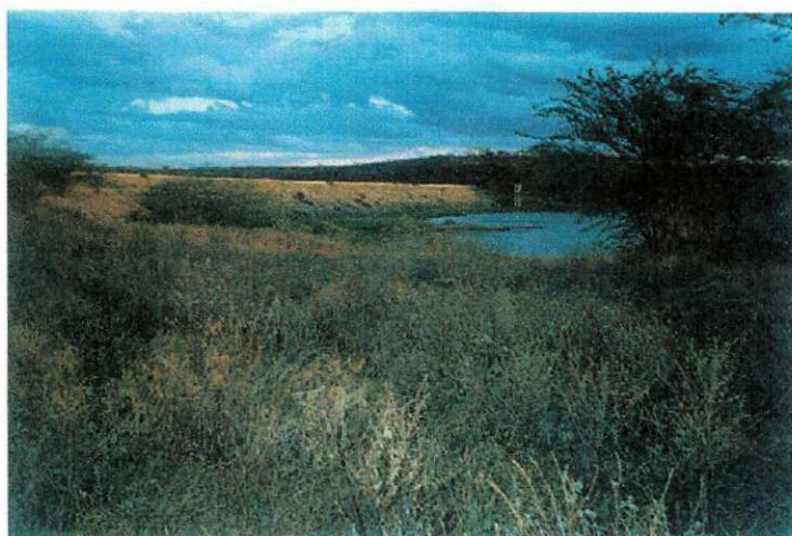
Foto 10 - Aspecto atual do Açude de Sumé, vendo-se ao fundo a sua barragem e a torre de tomada d'água.
