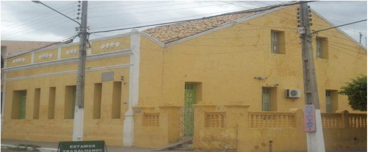
Foto 08- A residência apresenta o frontão com duas janelas, sua fachada evidência a platibanda. Tem duas portas de entrada localizada na fachada lateral e oito janelas, sendo seis na fachada frontal e duas na lateral. Na lateral apresenta também um pequeno jardim (foto da Autora, 2013).
