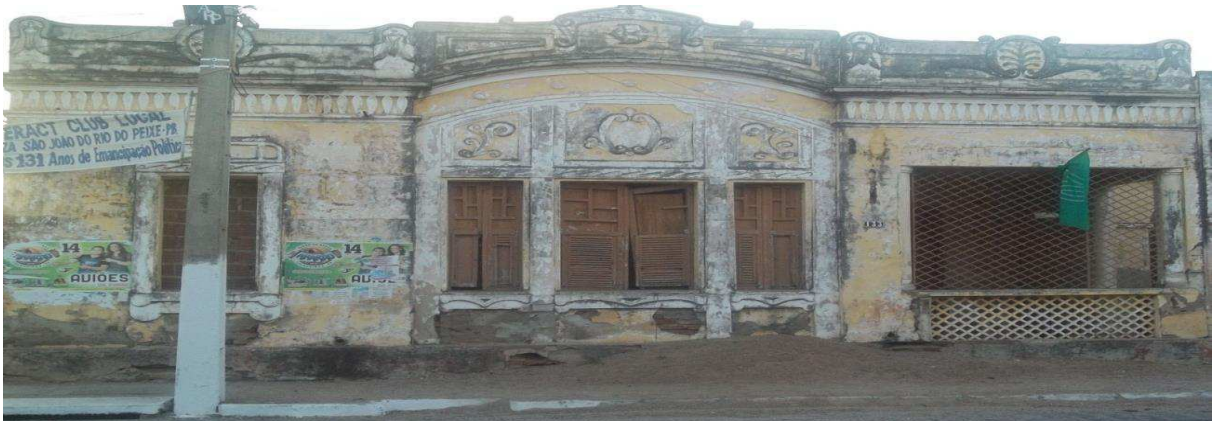
Foto 09 - Casarão da Rua Tabelião José Cândido Dantas. Parcialmente descaracterizado (foto da Autora, 2013).
