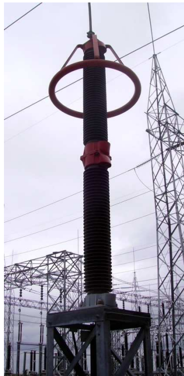
Pára-raios 74V4 Siemens 3EP21923PL4
