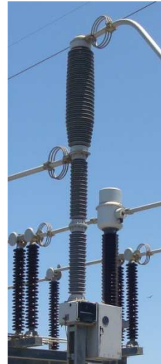
Disjuntor Siemens 3AP1 FI-245 com invólucro polimérico.
