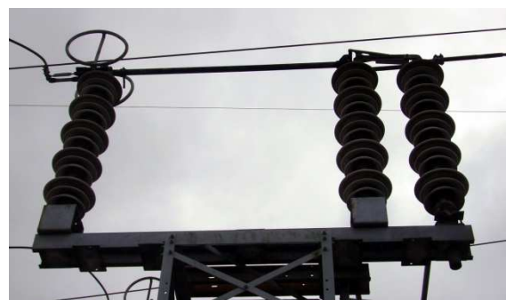
Chave seccionadora 34L3-5 Delle Alsthon DSV14
