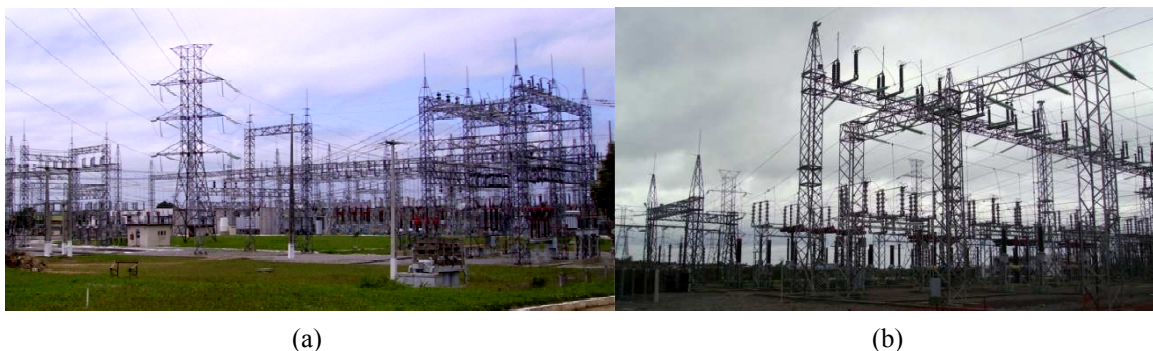
Figura 30. Fotografias da SE CGD; (a) Vista Oeste; (b) Vista Leste.
