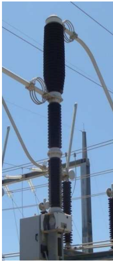
Disjuntor Siemens 3AP1 FI-245
