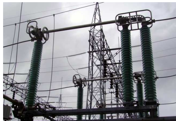
Chave seccionadora 34V4-5 Ceme S3CVT
