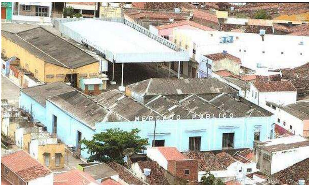
Figura 2. Vista aérea do Mercado Público de Cuité, ao fundo a área aberta do Arraial da Serra.
