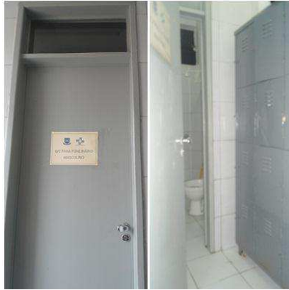
Figura 29 – Instalação sanitária masculina do Restaurante Universitário/CES
