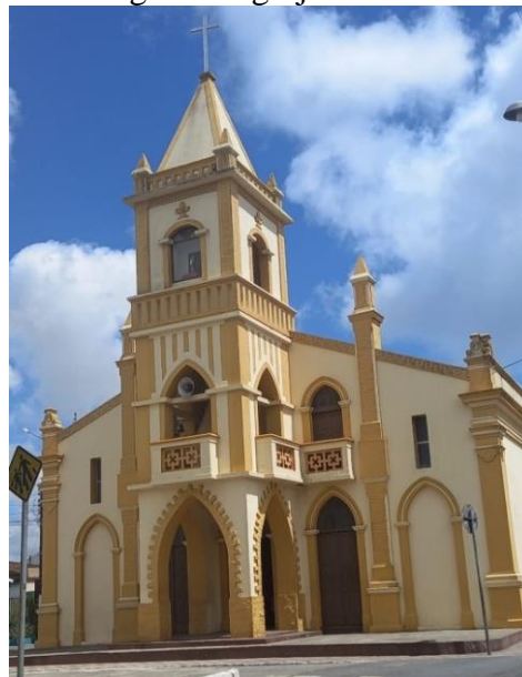
Figura 3- Imagem da igreja de São Sebastião
