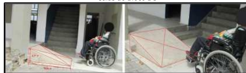
Ilustração 36–Rampa de acesso ao primeiro pavimento de salas do Bloco BC
