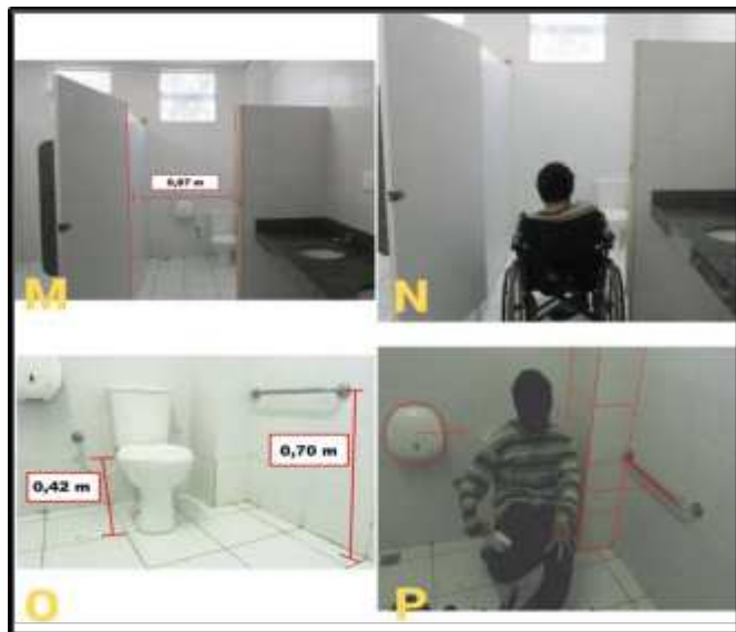
Ilustração 44–Banheiro acessível do Bloco BG (térreo)
